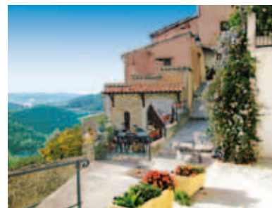
Ruelle du village plein sud
